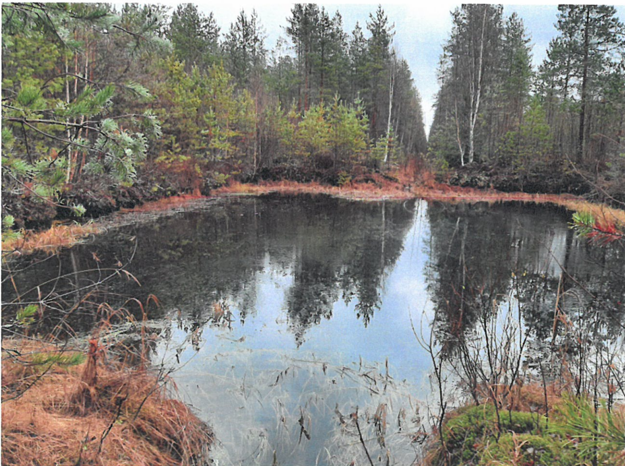
Kuva 5. Kiimanevanallas on suorakaiteen muotoinen. Altaan reunat ovat metsittyneet, mutta eivät haittaa putkipadon rakentamista (Metsänhoitoyhdistys Pyhä-Kala ry, Pylväs- ja Vasamaojan valuma-aluesuunnitelma 2022).
