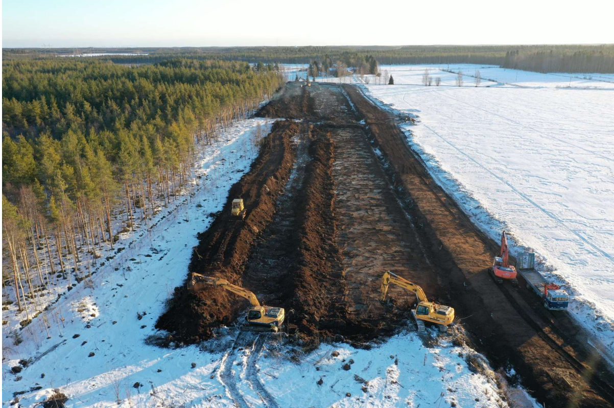
Kuva 4. Sulfaattipitoisten maa-aineksen vuoksi kaivuutyöt olivat normaalia työläämpiä, koska syvällä olevat maat haudattiin läjityspenkan keskelle. Kuva: Jusa Kokko, Luke.
