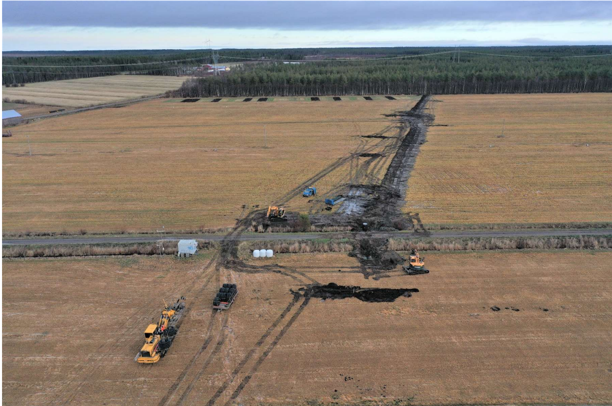
Kuva 3. Kastelualtaalta lähtevä ns. jakokanava kytkettiin turvepellon salaojastoihin. Altaan sijainti on pellon ja metsän reunassa (ei vielä kuvan ottohetkellä kaivettu). Kuva: Jusa Kokko, Luke.
