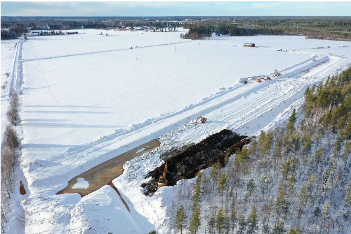
Kuva 6. Veden varastoaltaan kaivuutyöt toteutettiin talviaikaan, jotta koneet kantavat ja pakkaneen kuivattaa ylimääräisen veden pois. Kuva: Jusa Kokko, Luke.
