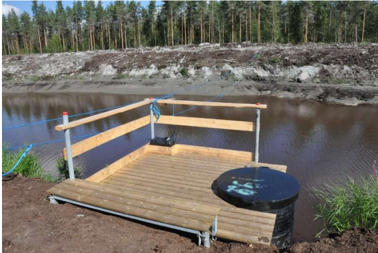
Kuva 9. Veden varastoallas melko tyhjänä heinäkuisen kastelujakson jälkeen. Kuvassa näkyy ns. syöttökaivo, josta vesi valuu painovoimaisesti pellon salaojastoihin. Kuva: Timo Lötjönen, Luke.
