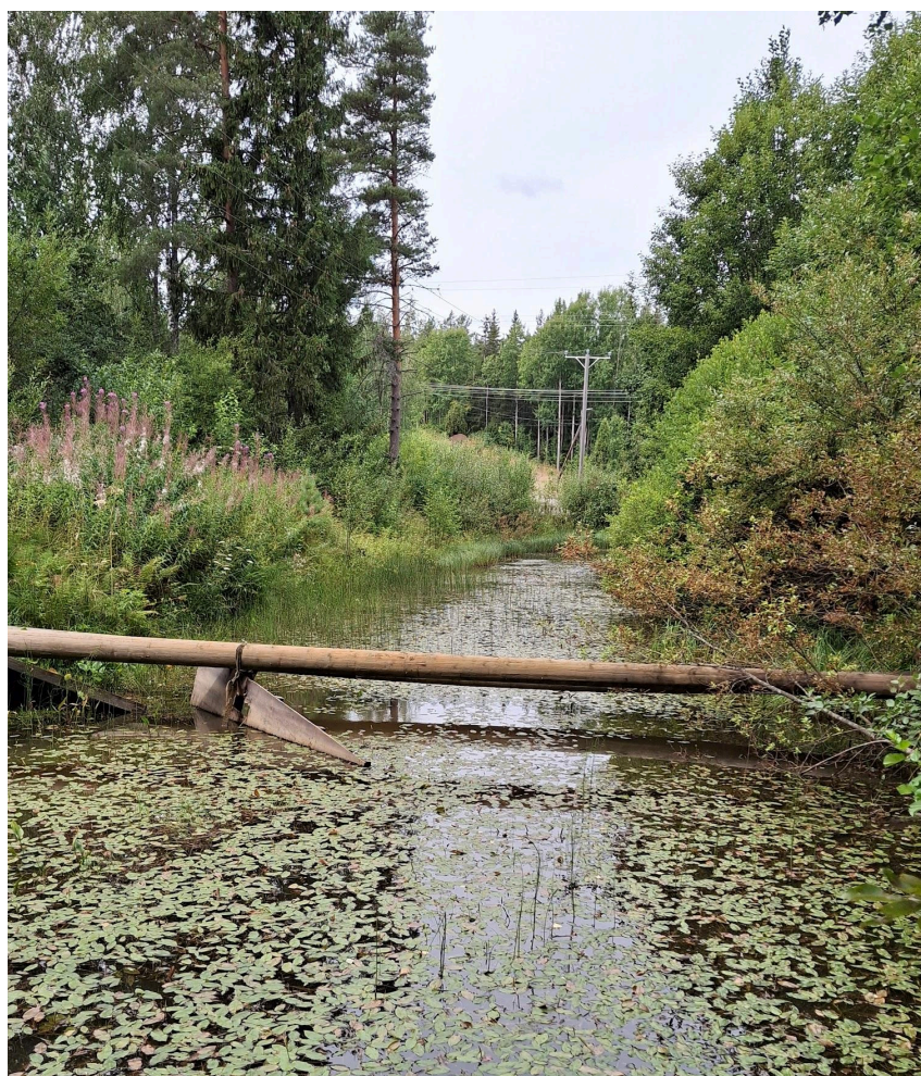
Kuva 8. Ojaan tehty allas, joka hidastaa laskuojan virtausta.
