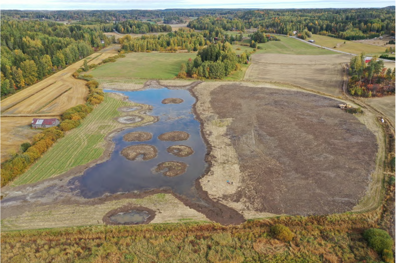
Kuva 7. Kahvimaan kosteikko juuri rakentamisen jälkeen syyskuussa 2022. Kaivuumassoilla korotettiin jäljelle jäänyttä peltoa, jolloin sen viljelyolosuhteet paranivat.
