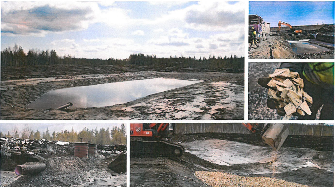
Kuva 1. Kuvia vesiensuojelurakenteen rakentamisen ajalta (Oulun kaupunki 2020).
