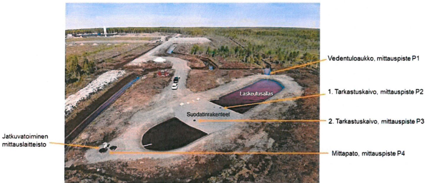
Kuva 2. Vesiensuojelurakenne ja vesinäytteiden ottopisteet. (Sirviö et al., 2020)
