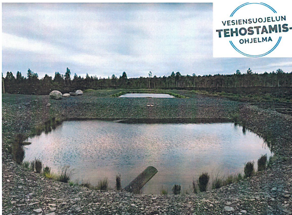
Kuva 3. Välimaan hulevesien pilottirakenne (Kuva: S. Pietola, Oulun kaupunki 2021).
