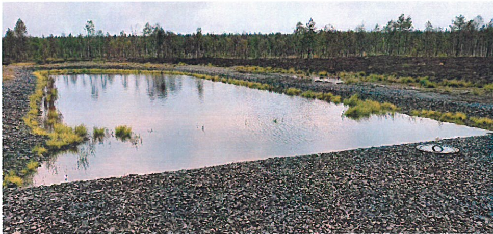
Kuva 15. Näkymä 1. laskeutusaltaan suuntaan suodatinrakenteen päältä 13.9.2021. Kuvassa myös 1. tarkastuskaivo.
