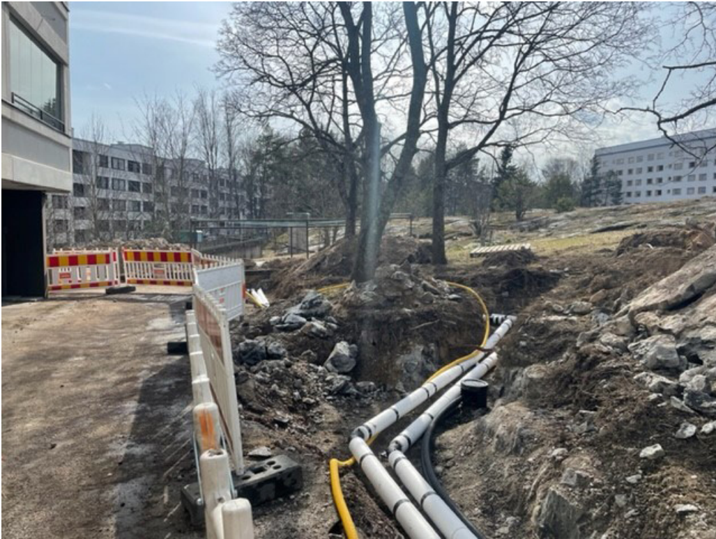
Kuva 10. Lämmönsiirtoputkien avoin kaivanto maalämpökaivoilta lämpöpumpulle. Kuva: Ramboll Finland Oy.
