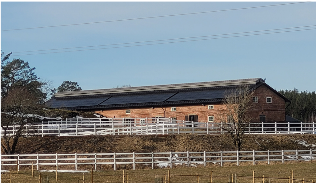
Kuva 12. Kuitian kartanon navetan katolla aurinkopaneelien kehykset on maalattu mustiksi. Kuva: Pekka Heikkinen/Qvidja Gård
