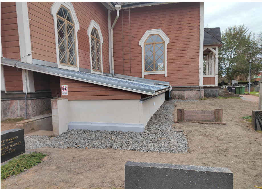
Kuva 23. Maalämpöjärjestelmän asennuksen jälkeen seinä ennallistettiin. Kuva: Jukka Hammaren/FinProma Oy.
