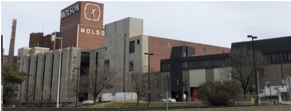
Kuva 12 Muurausliikkeen toteuttama tiilien uudelleenkäyttö julkisivukorjauksessa, Montreal
