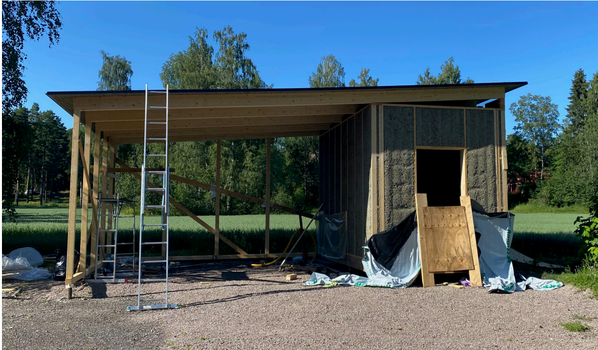
Kuva 7: Valmiiksi asennettu kehikko.
