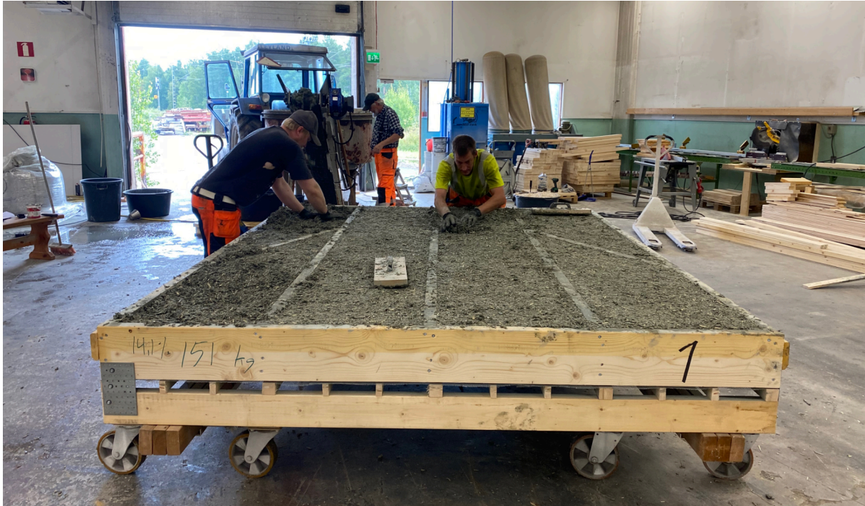
Kuva 4: Savimassaa sullotaan elementin sisään.
