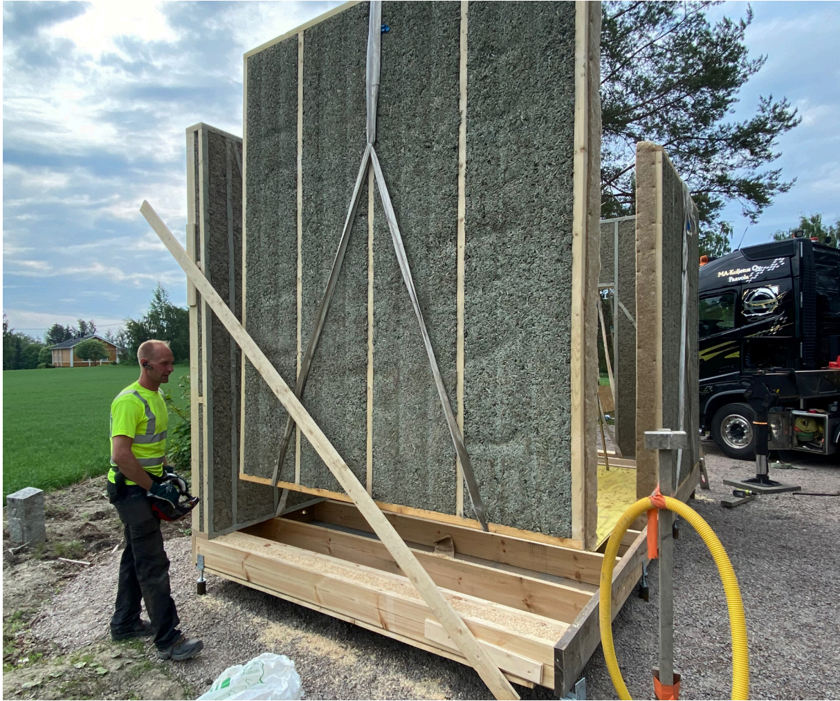
Kuva 6: Elementin asennusta nosturilla.
