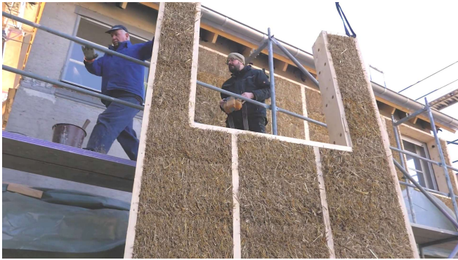
Lorenzin elementin nosto rakennuksen lisäeristeeksi [5]
