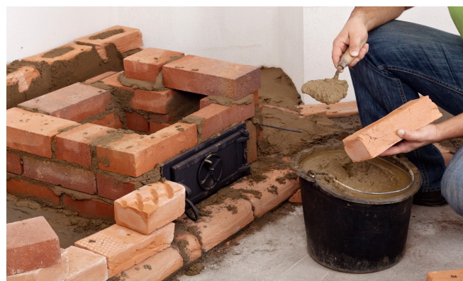
Tulisijan rungon muuraus Fesconin uunilaastilla [6]
