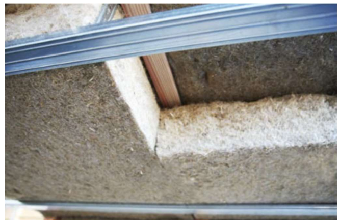
Biofibrin eristevilla välipohjan eristyksessä [2]
