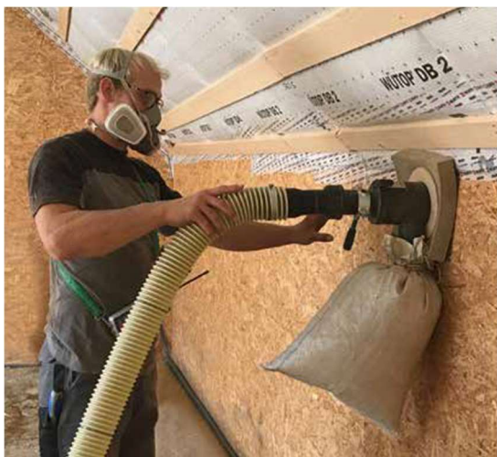
ISO-Strohn eristeen puhallusta seinärakenteeseen [2]
