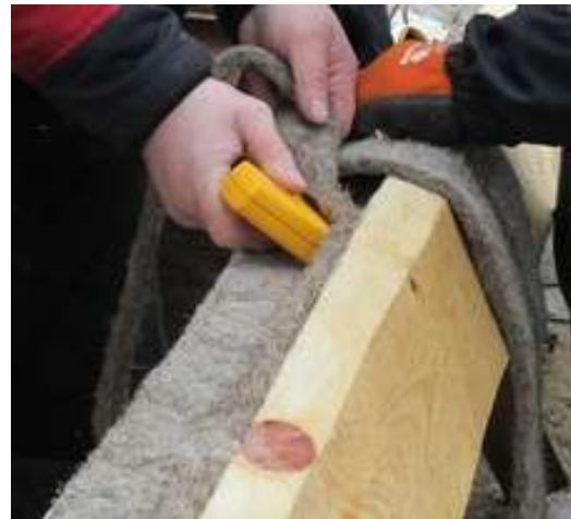
Isolinan pellavanauhan asennusta [3]
