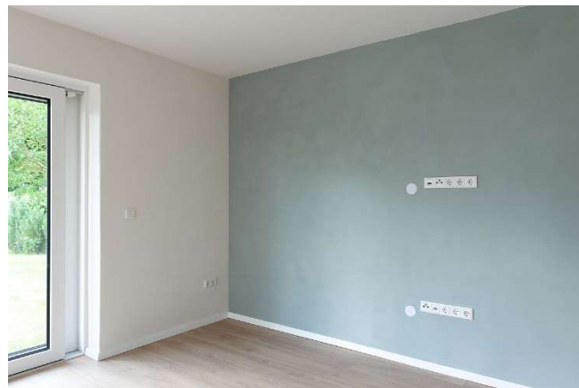
Conlutan väri-laasteilla pinnoitettu uudisrakennus [2]
