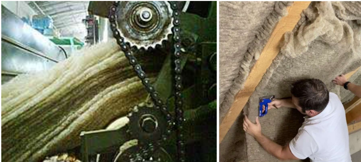
Kuva 6. Lampaanvillaeristeen valmistusta vas. (Isolana) ja asennusta oik. (Schafwolldämmung).
