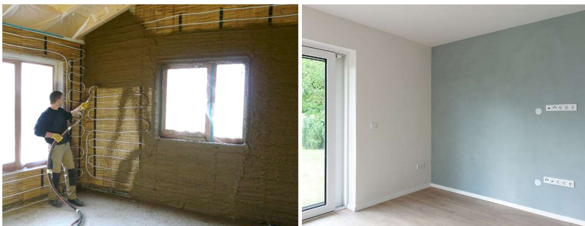
Kuva 10. Saviilaastin ruiskurappaus vas. (Levita Lehm) ja valmista pintaa oik. (Conluto).
