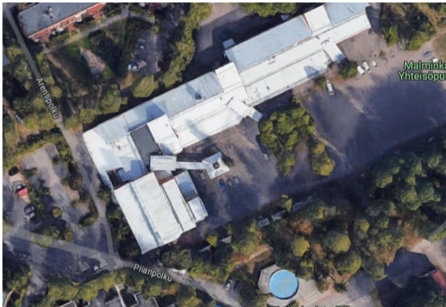
KUVA 24 CASE-KOHTTEEN ILMAKUVA JA YMPÄRISTÖ, HELSINKI, MALMINKARTANO.
