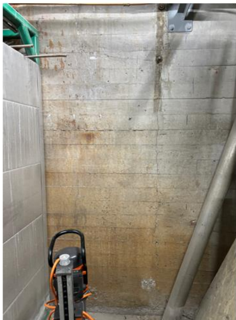
Kuva 4 Sisärakenne noin vuodelta 1965 (vasemmalla), josta porattu koekappale (oikealla).
