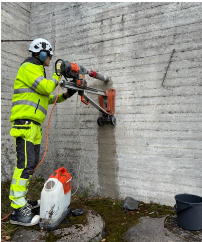
Kuva 3 Näytteenotto vuodelta 1965 olevasta ulkorakenteesta karbonatisoitumistutkimuksiin.
