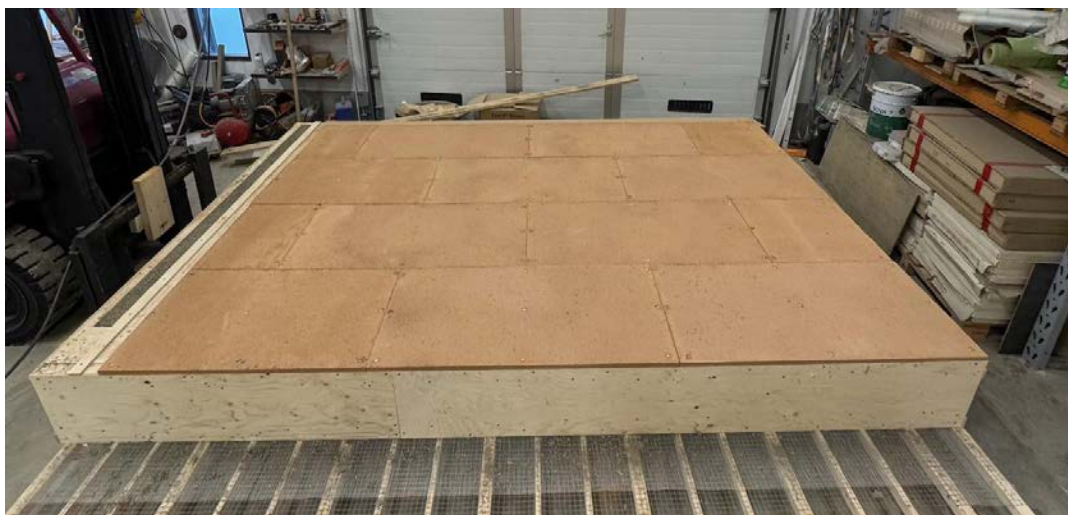
Elementin sisäpuolelle on kiinnitetty savilevy.
