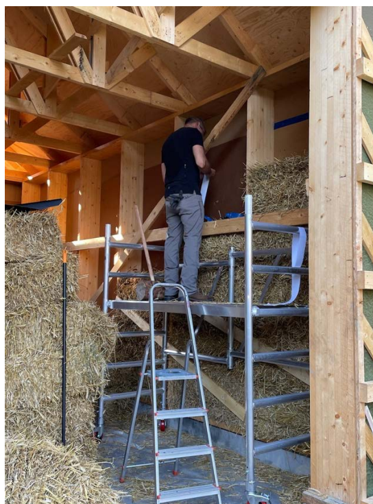
Kierrätysliimapuurunko ja olkipaalien asennusta kesällä 2024
