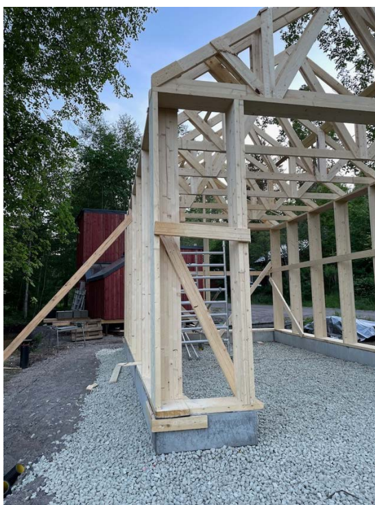
Kierrätysliimapuurunko ja olkipaalien asennusta kesällä 2024
