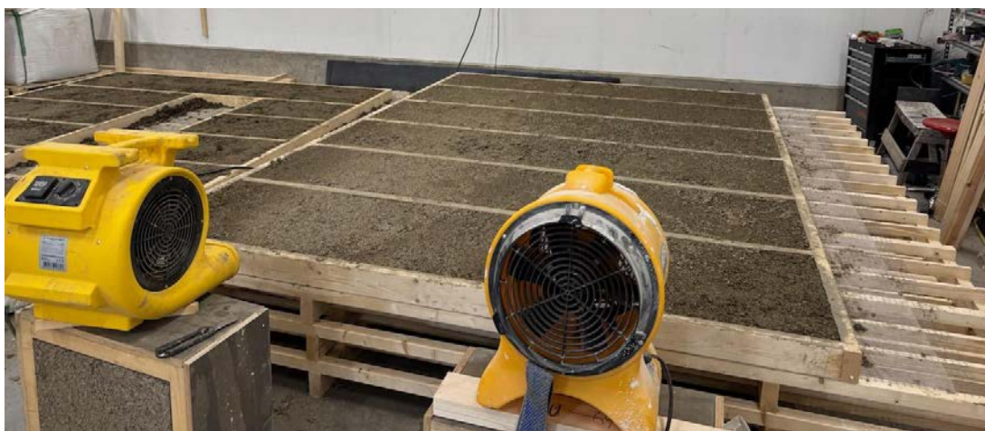
Ulkokuori on täytetty. Simpukkapuhallin (vasemmalla), jonka ilmavirta pyyhkii elementin pintaa, kuivaa elementtiä paremmin kuin tavallinen puhallin (oikealla). Elementin alla näkyy kuivausalusta, joka mahdollistaa kuivumisen alhaalta päin.
